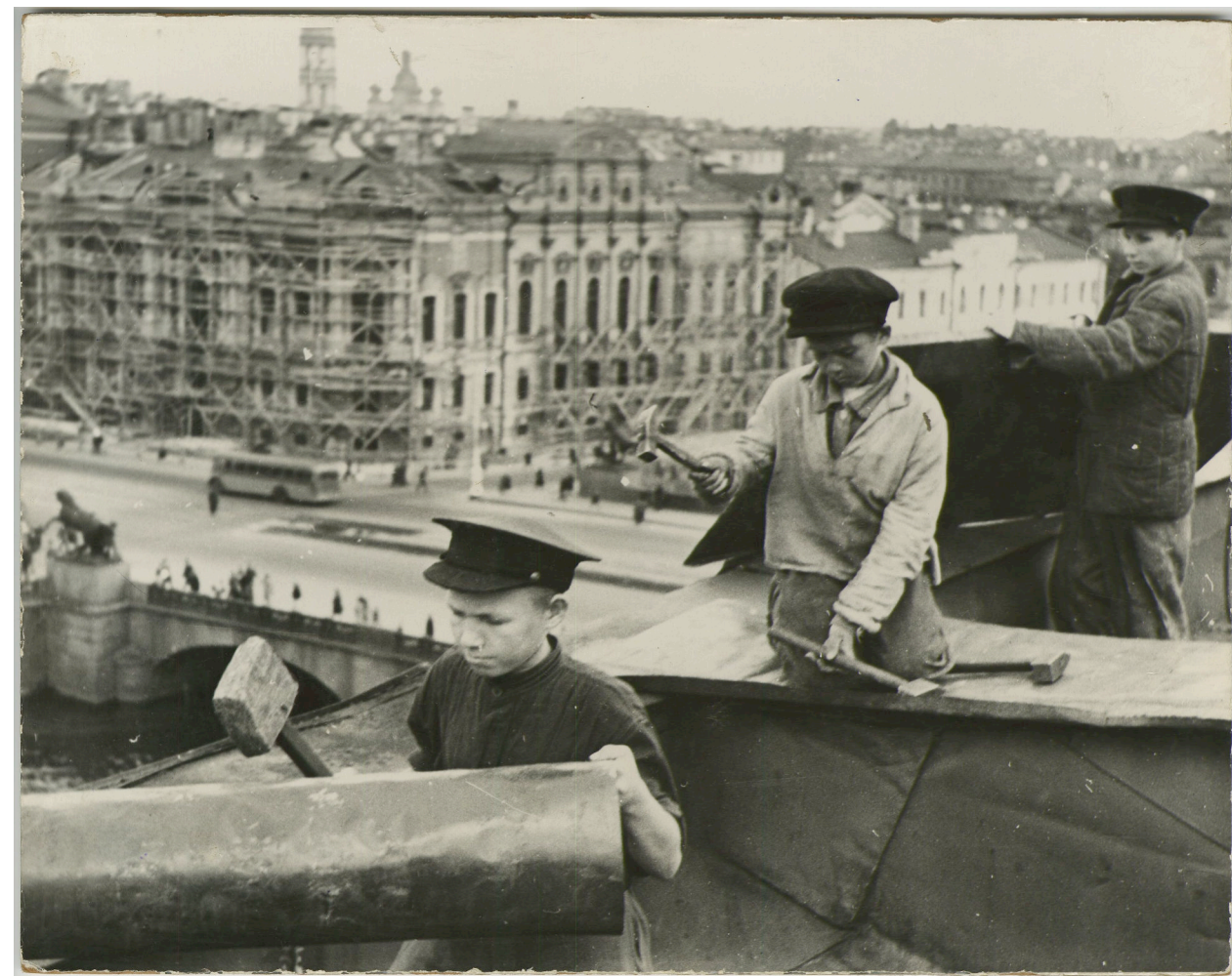
Ученики-отличники школы ФЗО № 7, кровельщики Анатолий Егоров, Сергей Горячев и Николай Иванов ремонтируют кровлю здания на набережной реки Фонтанки, на втором плане - Аничков мост. С.Е. Кропивницкий. Ленинград, 8 сентября 1945 г. Санкт-Петербургский музей истории профессионального образования
