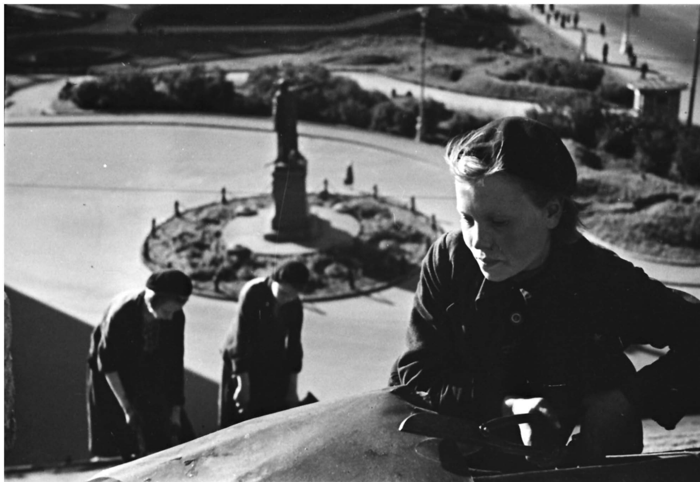
Молодые кровельщики, окончившие школу ФЗО, ремонтируют крышу: (на переднем плане) - Тамара Симанова. Лосин Б.С. Ленинград, 21 сентября 1943 г. Центральный государственный архив кинофотофонодокументов Санкт-Петербурга
